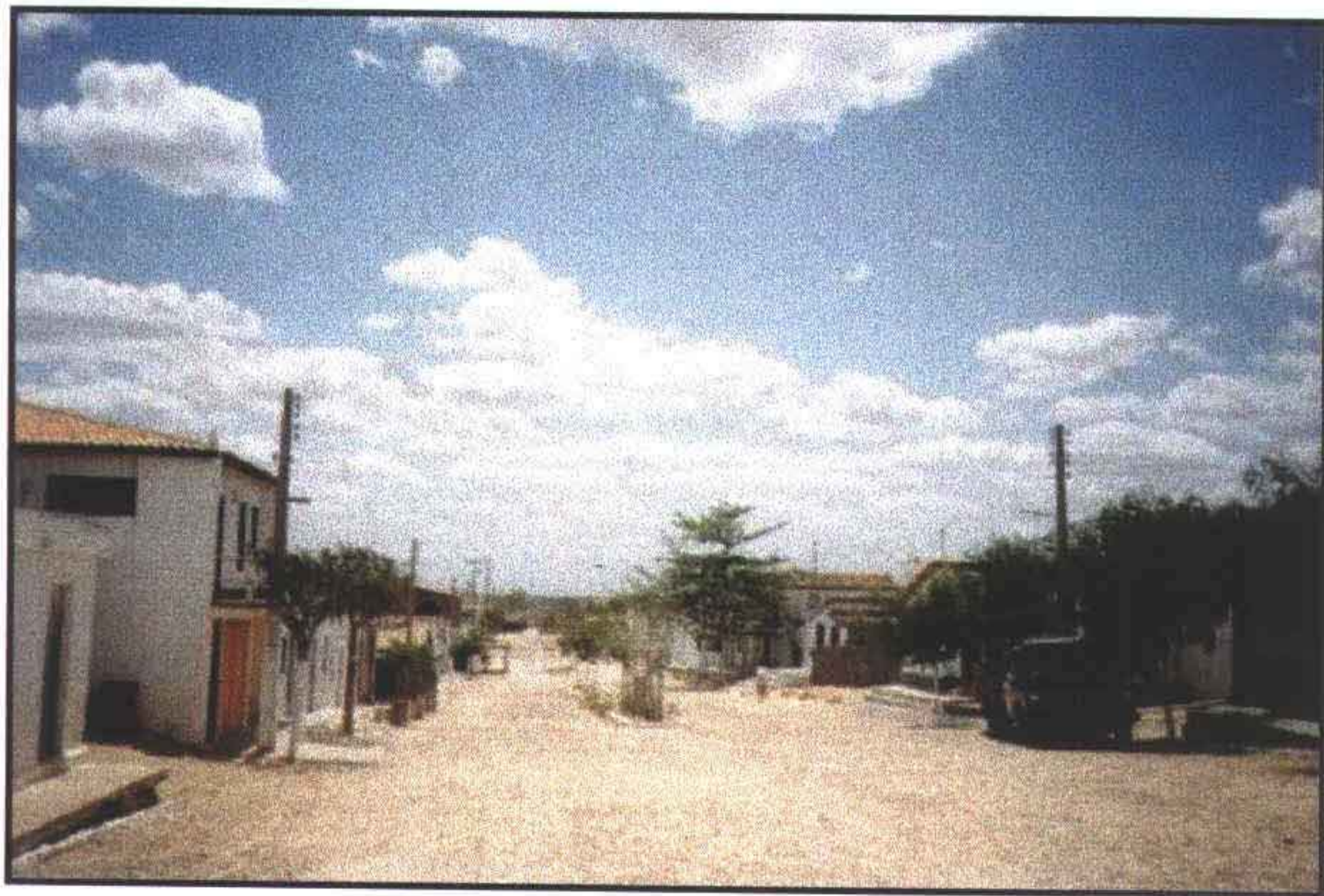
FOTO 04 - VISTA DO CAMINHAMENTO DA ADUTORA NA AV. CENTRAL DE LISIEUX
